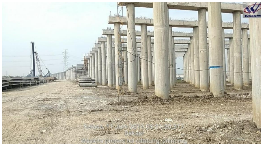
Gambar 6. Kondisi Full Slab di lokasi proyek
