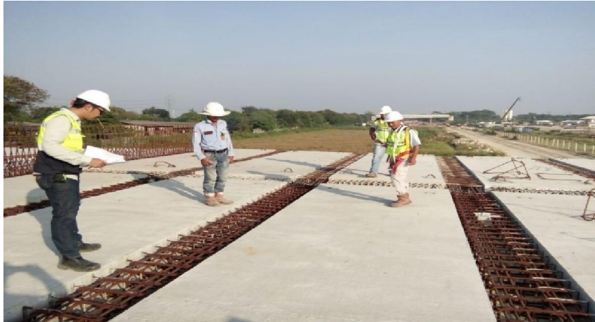
Gambar 5. pemasangan Full Slab di lokasi pileslab
